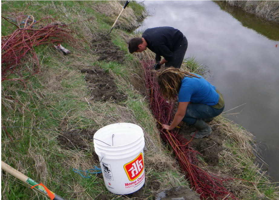
Installation d'un fagot sur les berges du ruisseau Dufort (Ferme Baril Bon Lait, Lorrainville)
