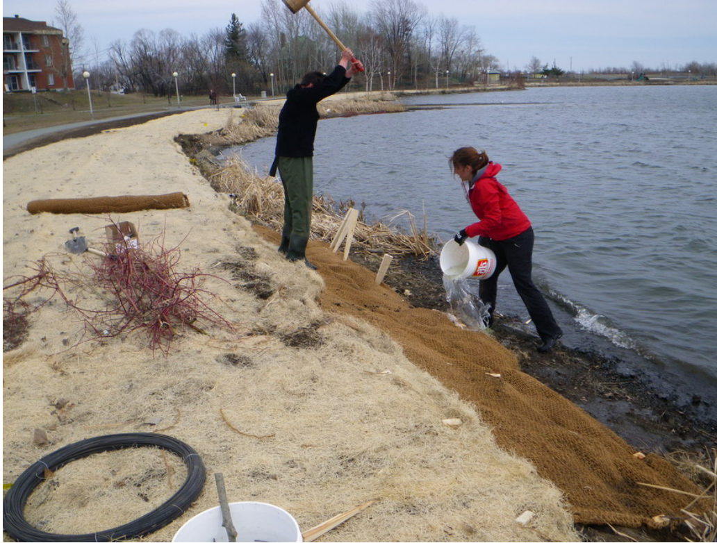
Installation d'un fagot avec membrane de coco au parc Trémoy (Rouyn-Noranda)
